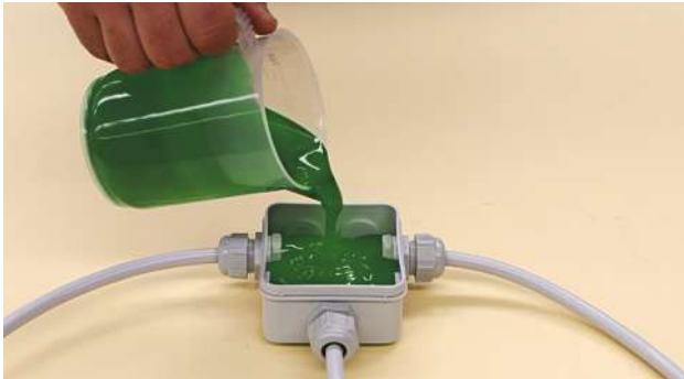
Verter el producto preparado en la caja de sellado. Esperar unos 10 min. (20°C) para una reticulación total.
